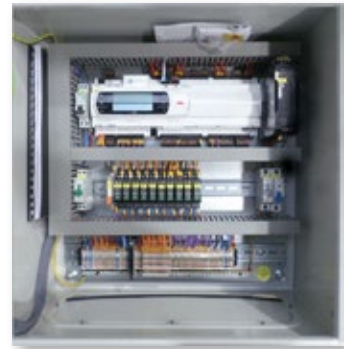
Fig. 1.f - Quadri elettrici con elettronica CAREL
