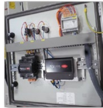
Fig. 1.f - Quadri elettrici con elettronica CAREL
